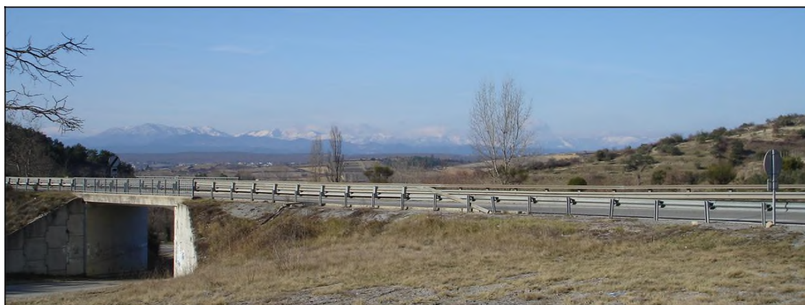
Photo : depuis la RN102 vers les Cévennes
