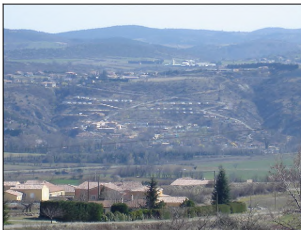
Photo : le parc résidentiel de loisirs des Pommiers implanté sur le coteau de la Claduègne, vu depuis Mirabel, avec en arrière-plan le secteur du Plan de Buns (anciens poulaillers)
