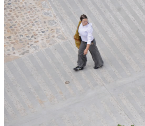
Pochoir en bande sur béton sablé
