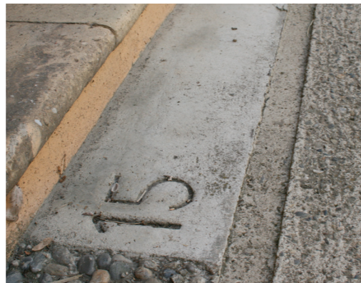
Traitement des seuils avec adresse engravée - Grisolles (82)
