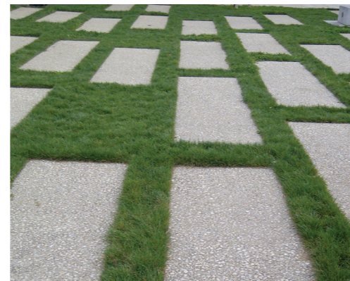
Pas japonais avec dalles de béton désactivé
