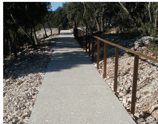
Cheminement piéton en béton sablé Gorges de l'Ardeche
