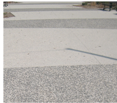
Sol avec alternance béton sablé et béton désactivé
