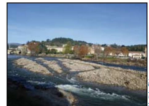
Favoriser le transport solide : brassage des matériaux et ouverture de chenaux dans un banc de galets
