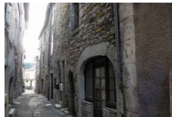
Pour lutter contre la précarité énergétique.
