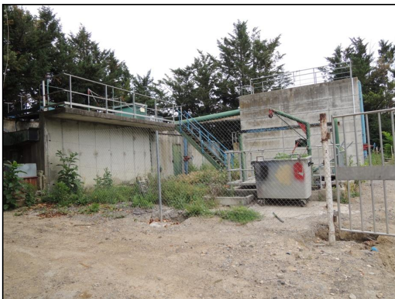
Point de déversement des eaux usées de Vallon-Pont-d'Arc dans l'Ibie en cas de dysfonctionnement des dégrilleurs et ancienne STEP de Vallon-Pont-d'Arc située en bordure du lit de l'Ibie.
