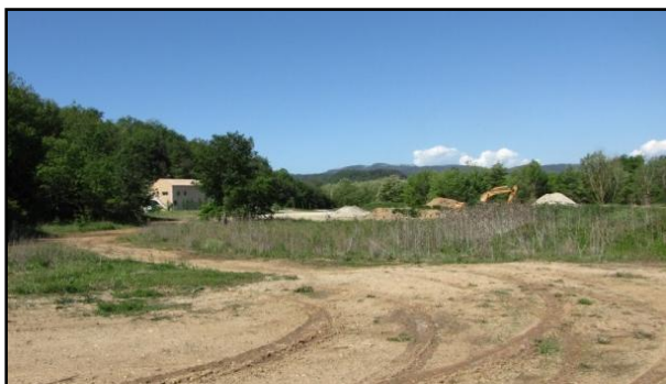
STEP de Vallon-Pont-D'Arc et friches environnantes
