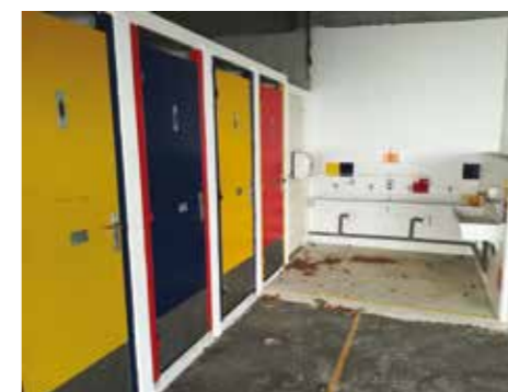
Les toilettes extérieures.
