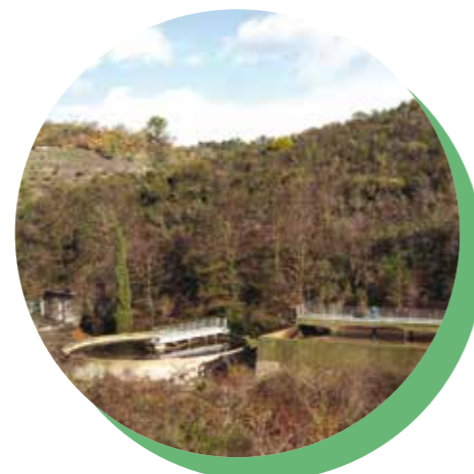
La station d'épuration.
